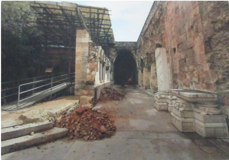
Fig. 5 . Ala sul do claustro, à esquerda o muro desmontado
